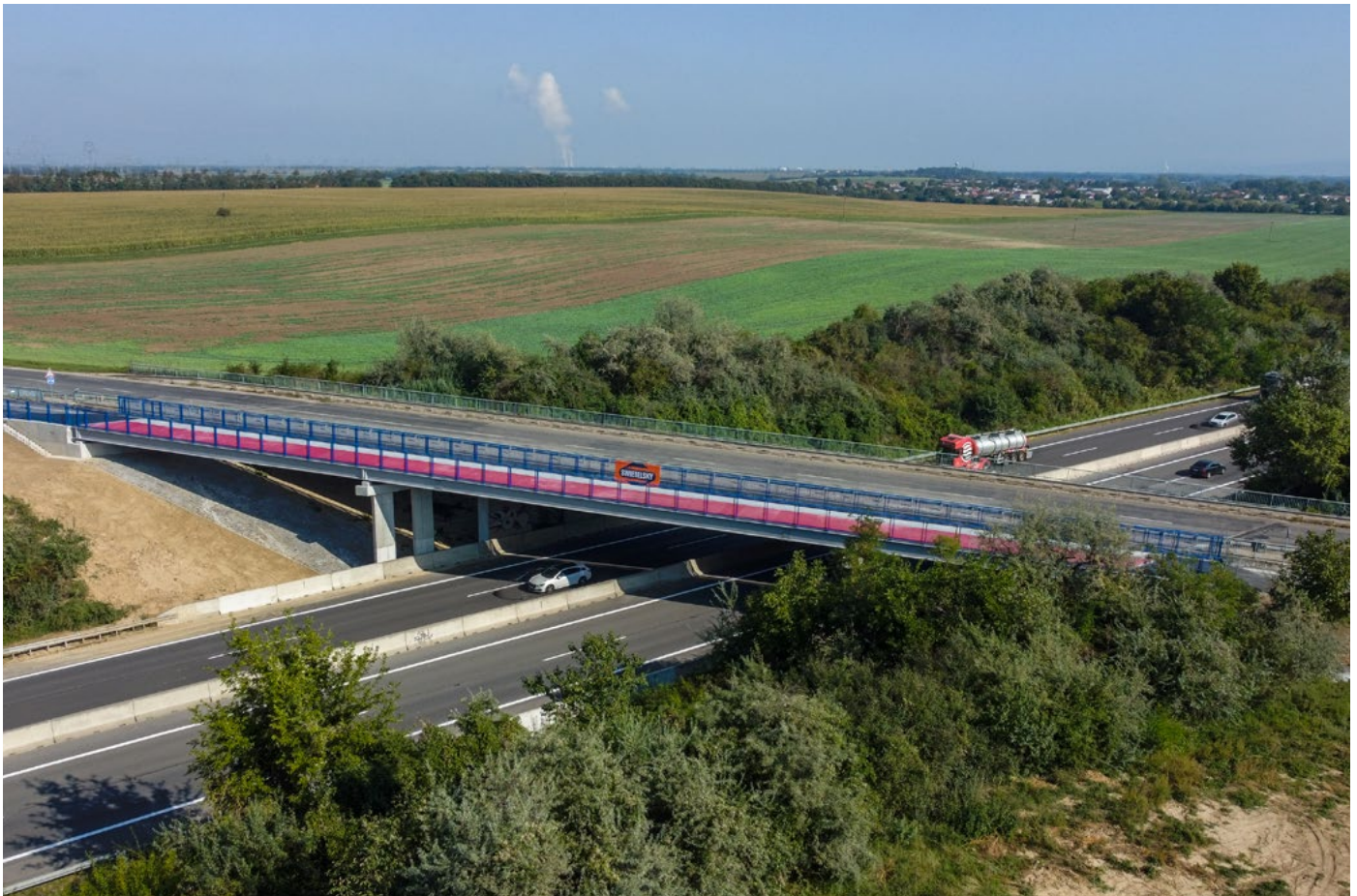
Erweiterung Brücke, Zavar, Slowakei
