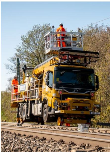
Schneebergbahn, Österreich Nijmegen–Roermond, Niederlande Korridorsanierung, Nürnberg–Neumarkt, Deutschland Penzing, Österreich
