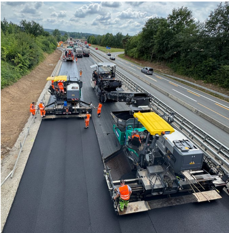
Fahrbahndeckenerneuerung B33, Deutschland
