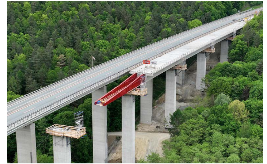
ARGE Talübergänge S31, Siegraben, Austria
